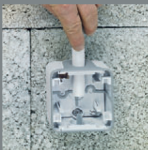
2/ Zasuňte trubku přes vytvořený otvor
